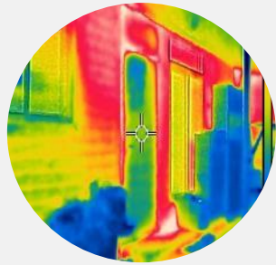
공사 후 (외부)
