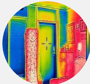
공사 후 (내부)
